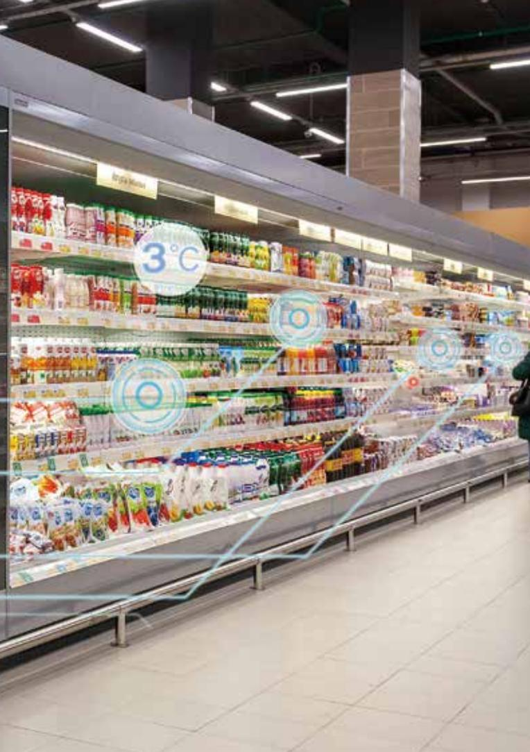
華冷鏈管理解決方案後，應用 LoRa 無線冷鏈感測器，打造出一個嚴密的監控網路，無論商品位在前方賣場、後方倉儲或物流中心的冷凍櫃，管理者都能經由雲端平臺，即時掌握目前冷凍櫃的溫度變化，避免商品因為溫度劇烈變化而變質的風險。
